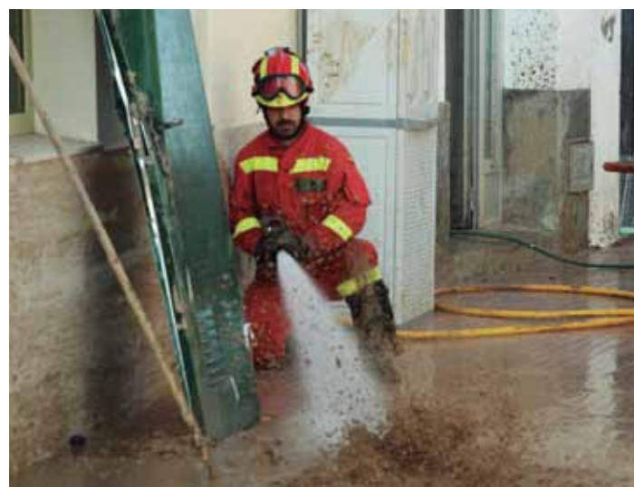
LIMPIEZA DE LODOS EN VERGER. / CLEANING SLUDGE IN VERGER.
