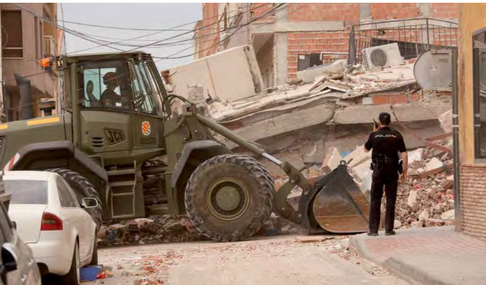
RETIRADA DE ESCOMBROS EN LORCA, MURCIA. / REMOVE RUBBLE IN LORCA, MURCIA.
