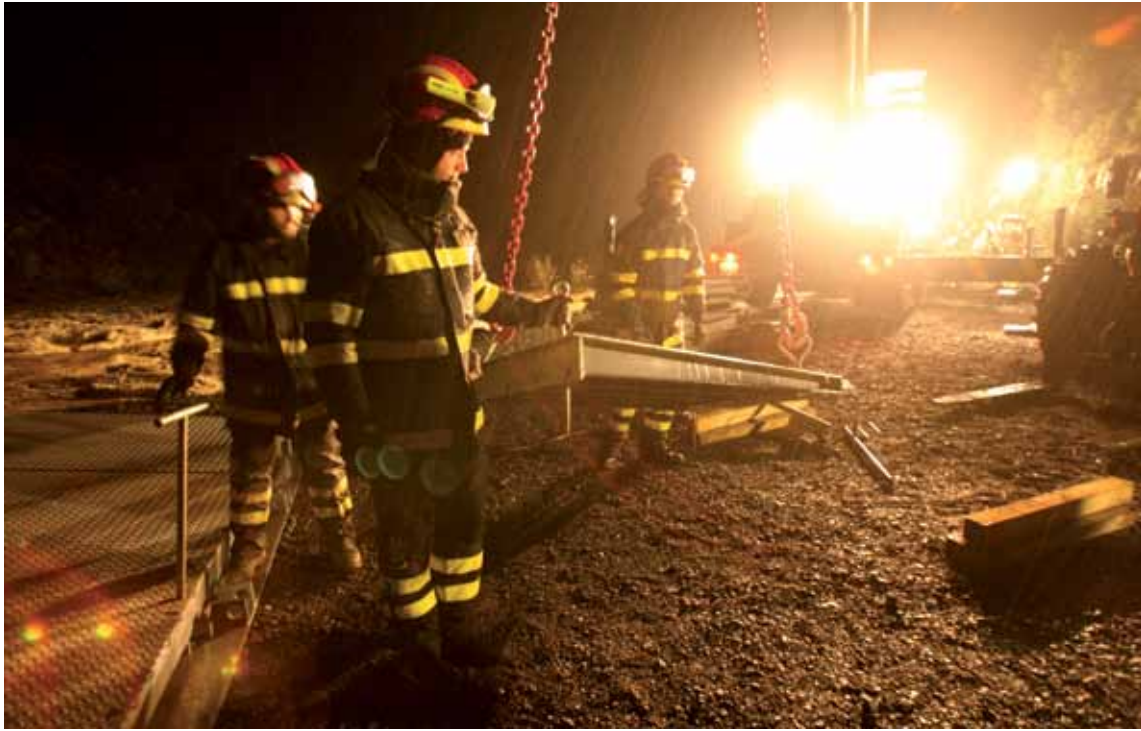
INSTALACIÓN DEL PUENTE MABEY EN MESTANZA, CIUDAD REAL. / BRIDGE INSTALLATION IN MESTANZA, CIUDAD REAL.
