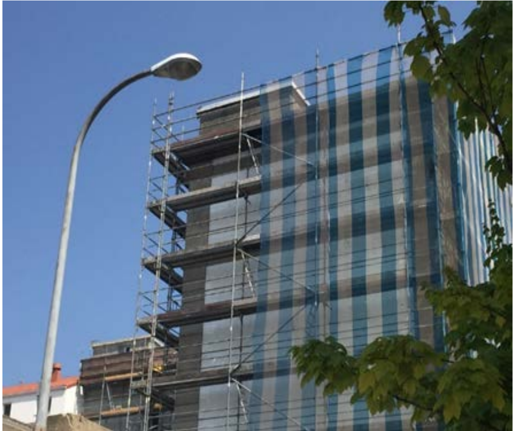
Reparación de fachada y cubierta en edificio de viviendas en A Coruña.
