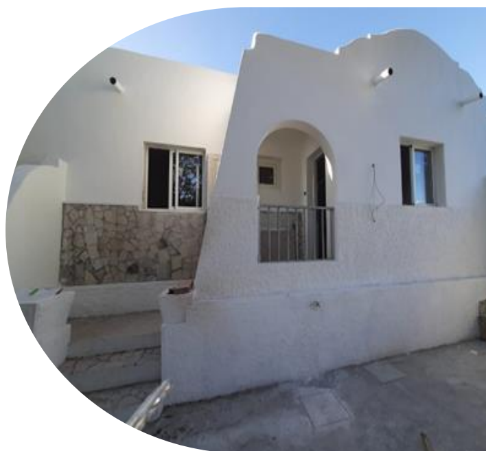
Rehabilitación vivienda Base Hoya Fría, Santa Cruz de Tenerife, Canarias.
