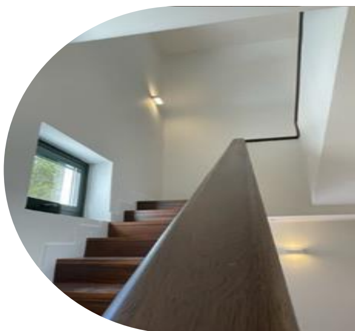
Obras de acondicionamiento de escalera en Pabellón de Cargo en Pontevedra
