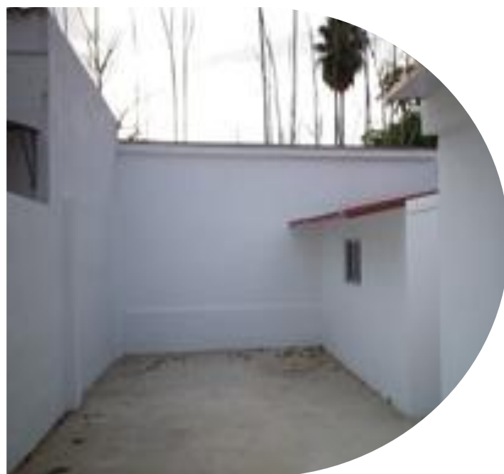
Obras de habitabilidad de viviendas en C/ Barrio Viejo, Sevilla
