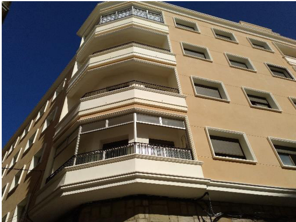
Rehabilitación de fachada en edificio de viviendas en Ceuta
