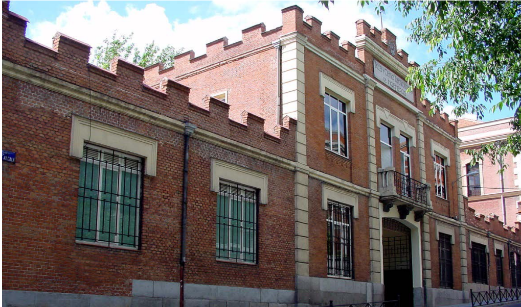
Antigua sede de la extinta GIED. Calle Princesa. Madrid.
