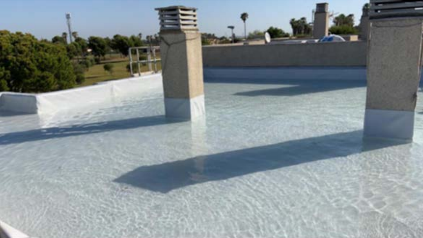
Prueba de estanqueidad de cubierta. Edificios en Poblado Naval de Rota. El Puerto de Santa María. Cádiz.
