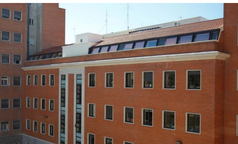
Imagen de la fachada interior del edificio de la sede central del INVIED O.A.
