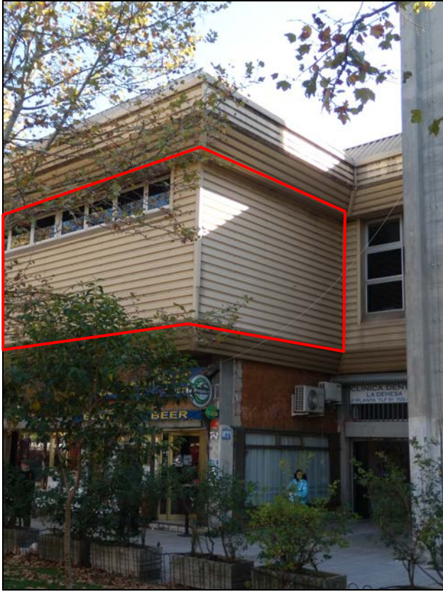
Vista de la fachada que da a zona peatonal
