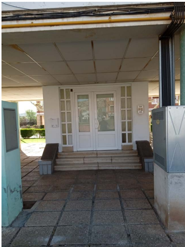
Puerta acceso al portal 8
