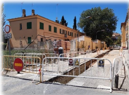
Ilustración 10 Obras para la mejora de la red de abastecimiento de agua en una colonia militar.
