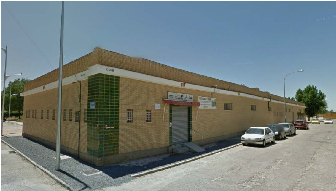
Fachada vista desde la calle Carlos Haya
