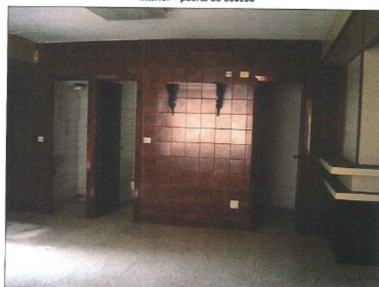
Interior – puertas aseos
