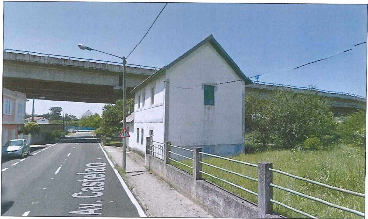
Panorámica de la edificación existente y parte de la parcela
