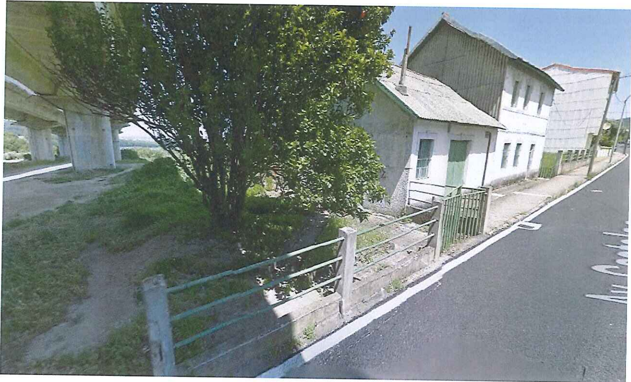
Vista de la parcela a la izquierda de la edificación
