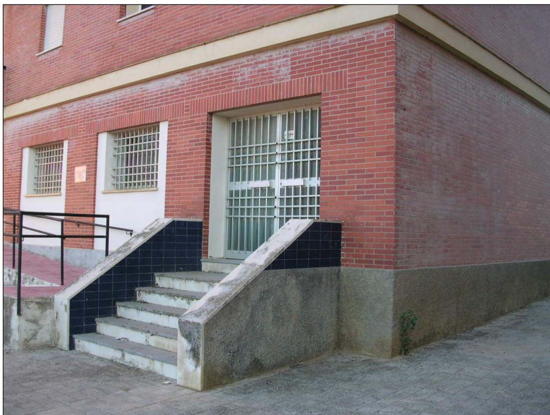
Fachada principal y lateral –Escalera y puerta de acceso-
