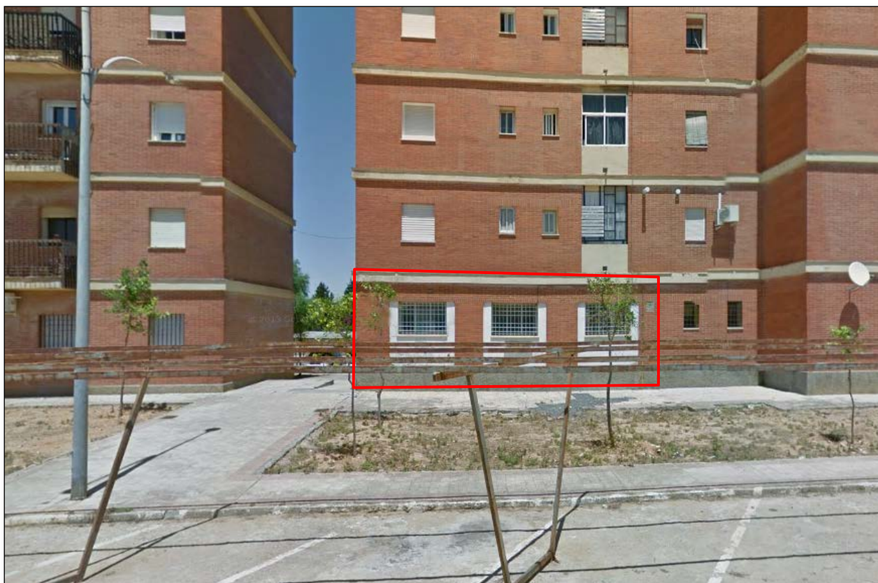
Fachada posterior al aparcamiento interior del conjunto inmobiliario
