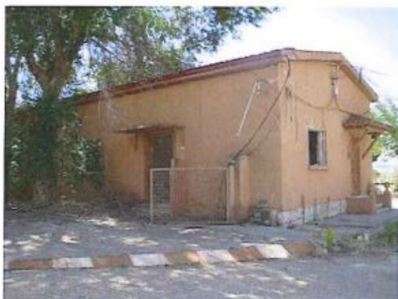
7.- Extremo oeste de la edificación nº 12
