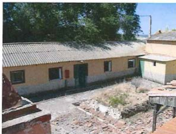
6.- Vista de la edificación nº 11, en su cara norte.
