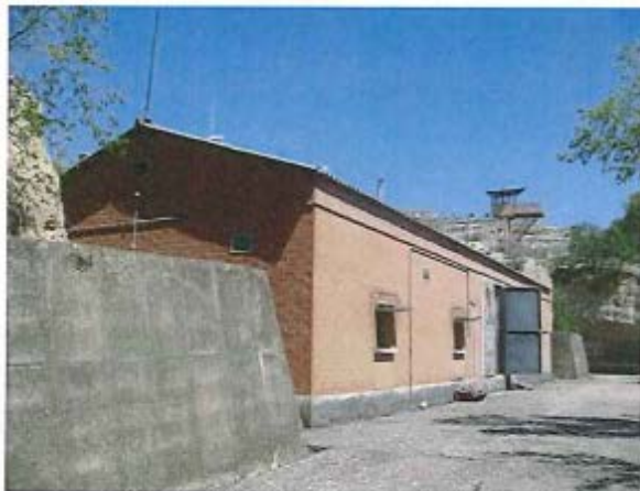
5.- Nave-almacén letra C (semejante a la letra D)
