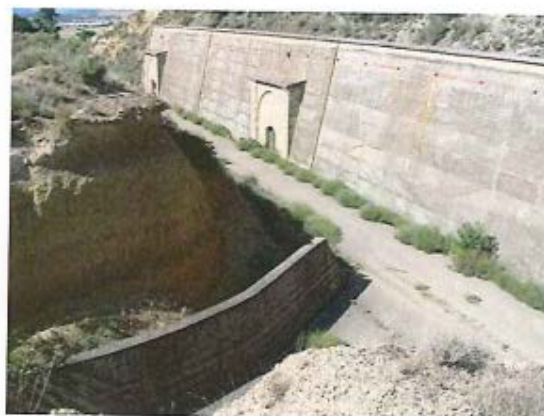
2.- Corredor de acceso a las criptas
