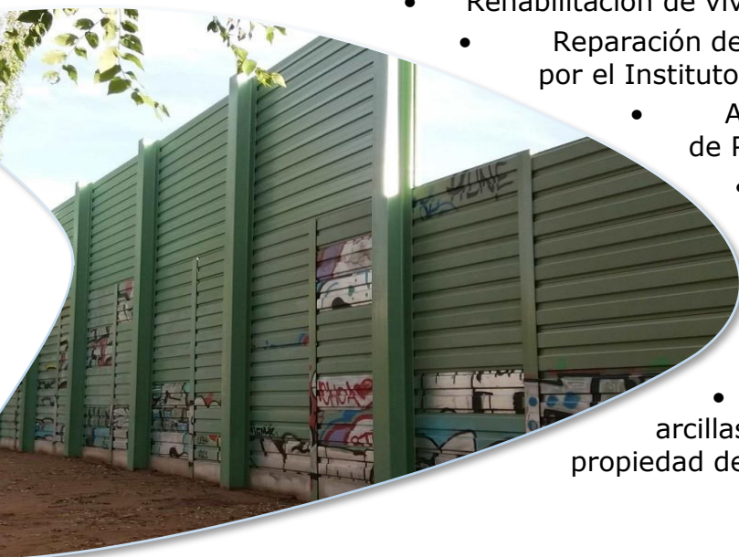
Ilustración 12. Montaje de pantallas acústicas.
