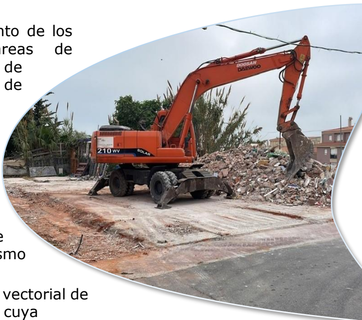
Ilustración 10. Excavadora durante una demolición.
