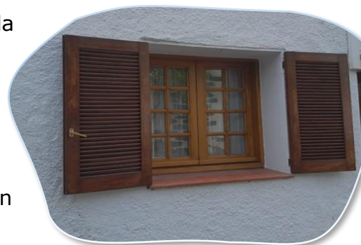
Ilustración 11. Instalación de nuevas ventanas.
