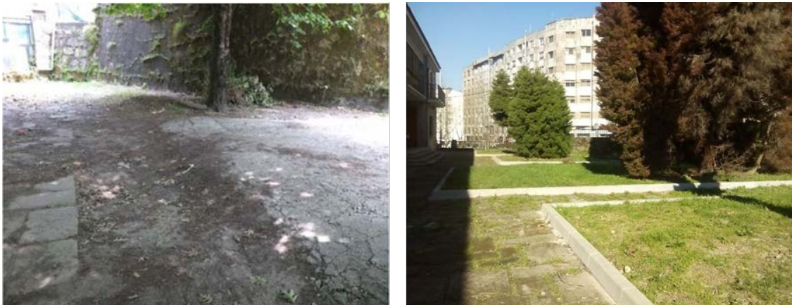
Obras de reparación de parterres en viviendas de Pontevedra
