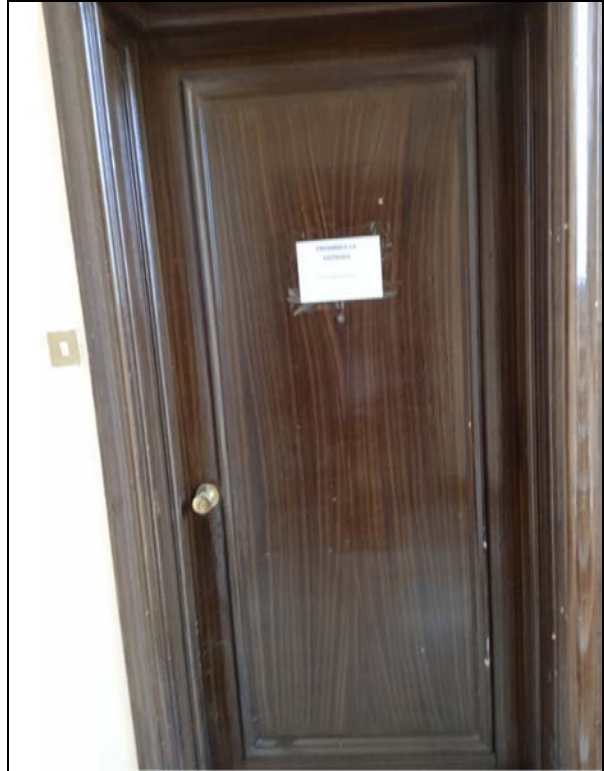
Puerta acceso a la vivienda
