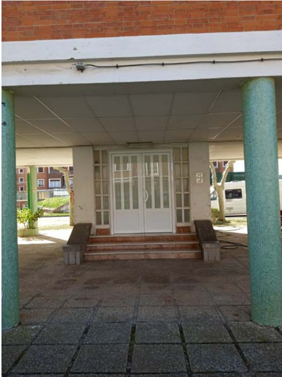
Acceso al portal 3
