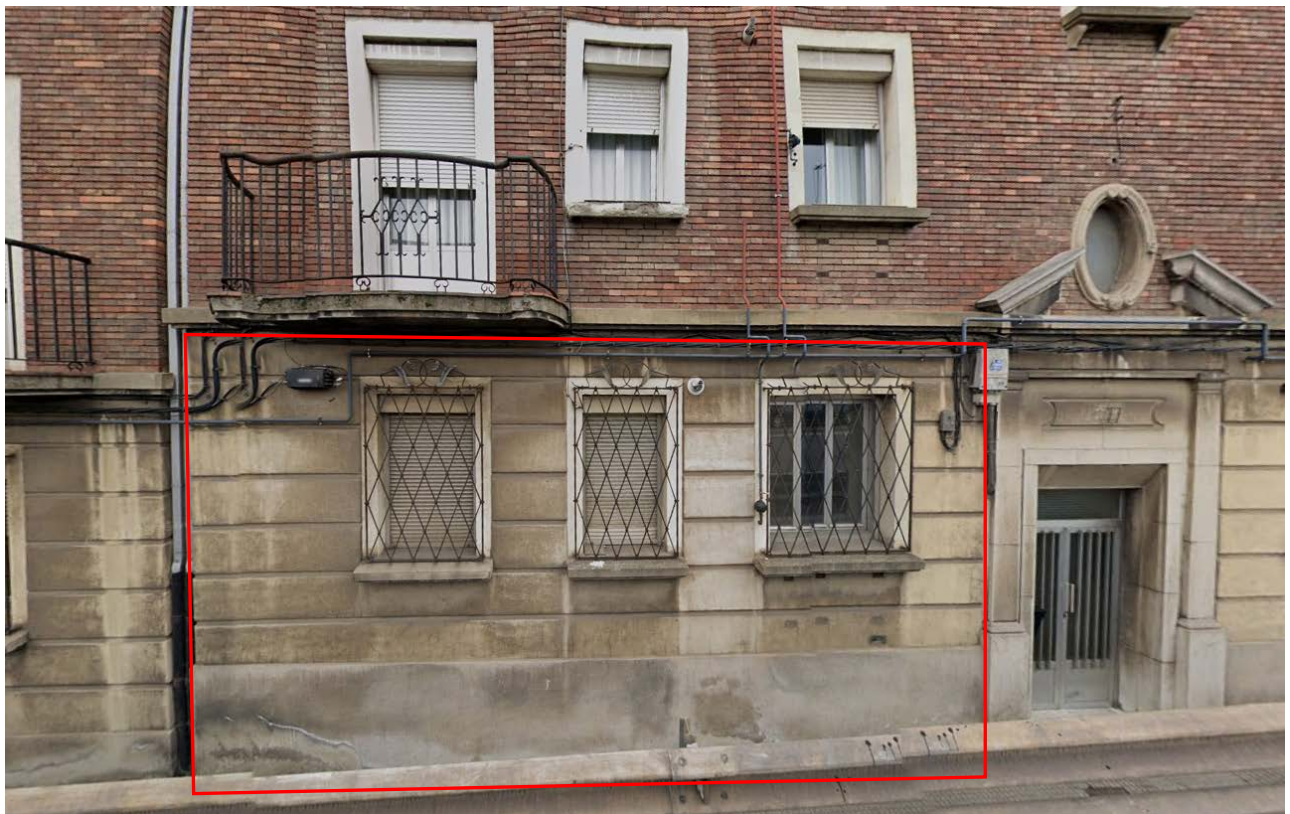
Detalle fachada principal de la vivienda – Tres ventanas
