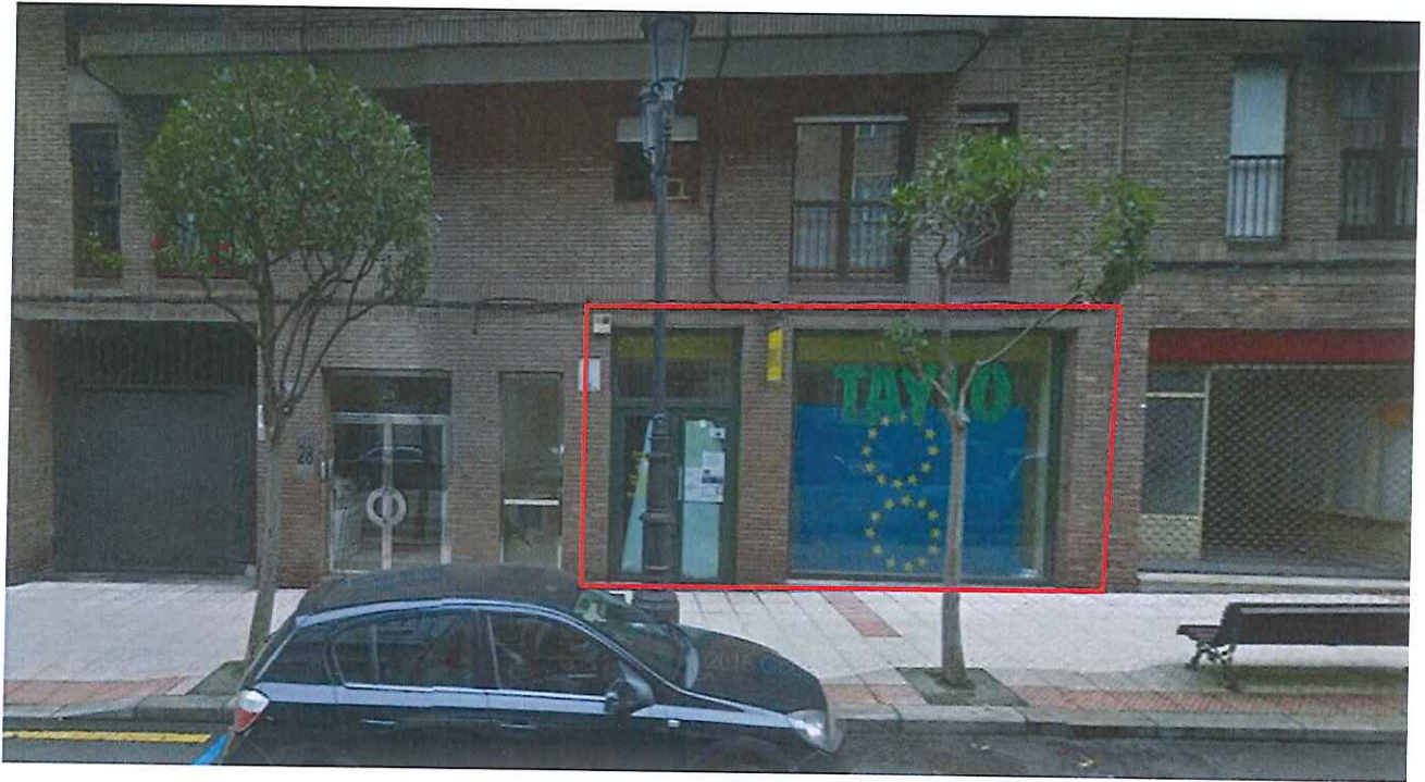
Fachada y puerta de acceso
