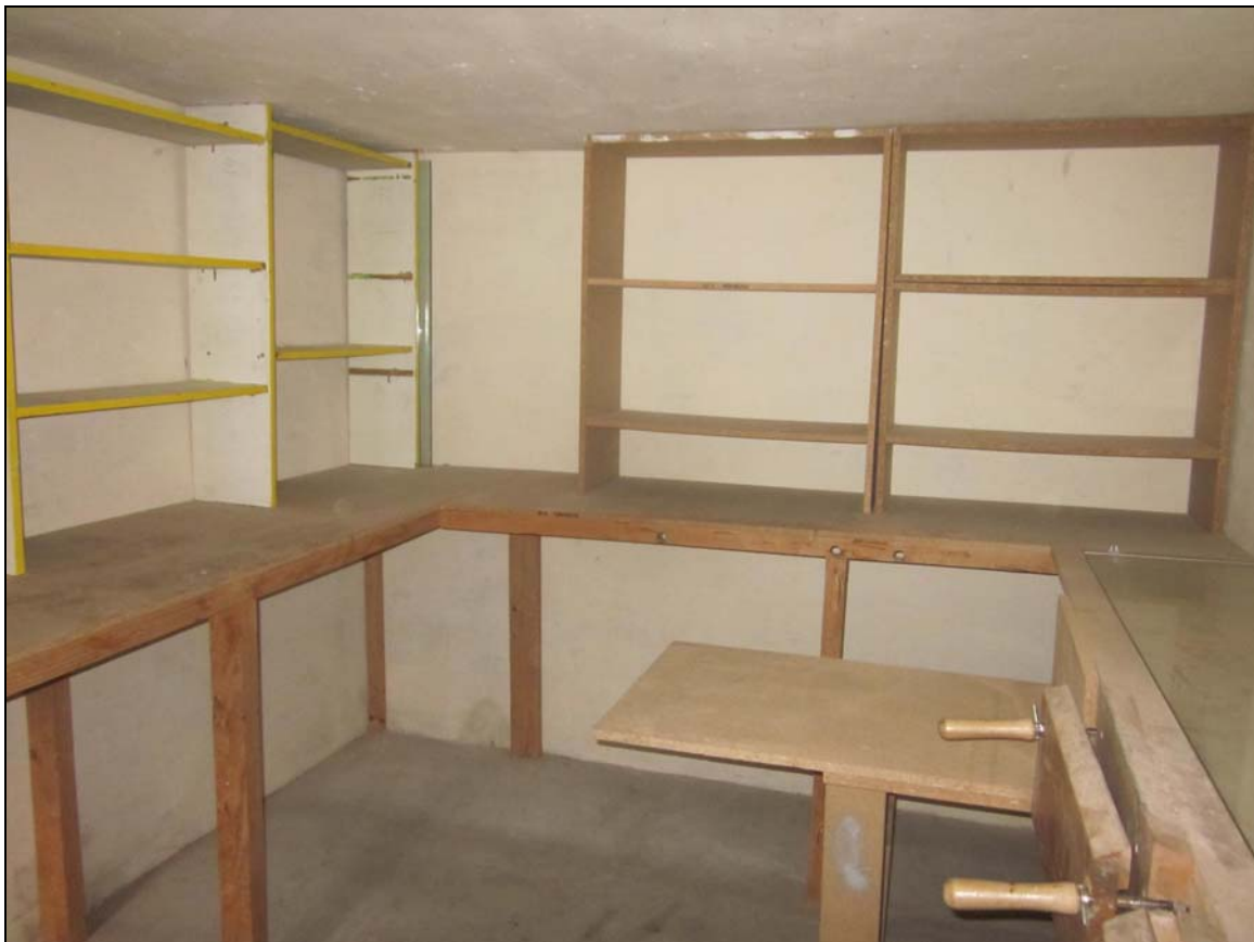
Vista interior local. Planta alta.
