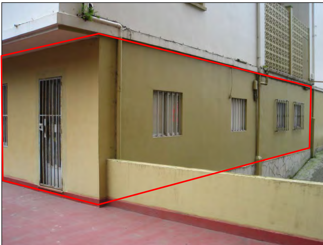
Vista de la fachada que da a la rampa de acceso al garaje
