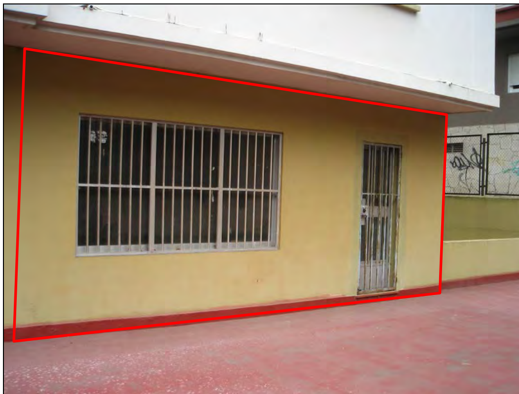
Fachada principal y puerta de acceso
