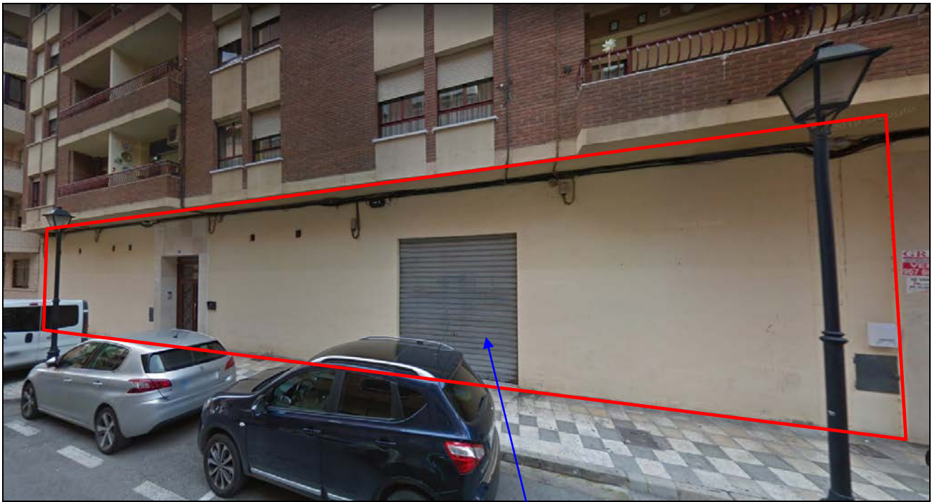
Fachada y puerta de acceso a calle Ciudad Real
