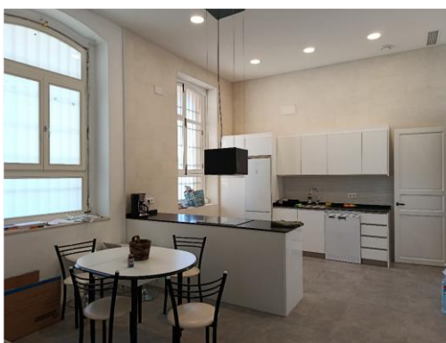
Ilustración 2 Obras de rehabilitación de una cocina en un edificio plurifamiliar.
