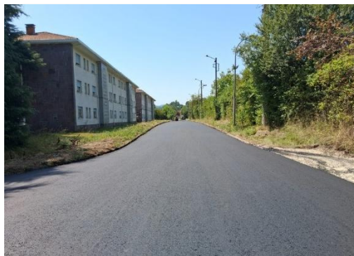
Ilustración 3 Obras para la mejora de la red de abastecimiento de agua en una colonia militar.
