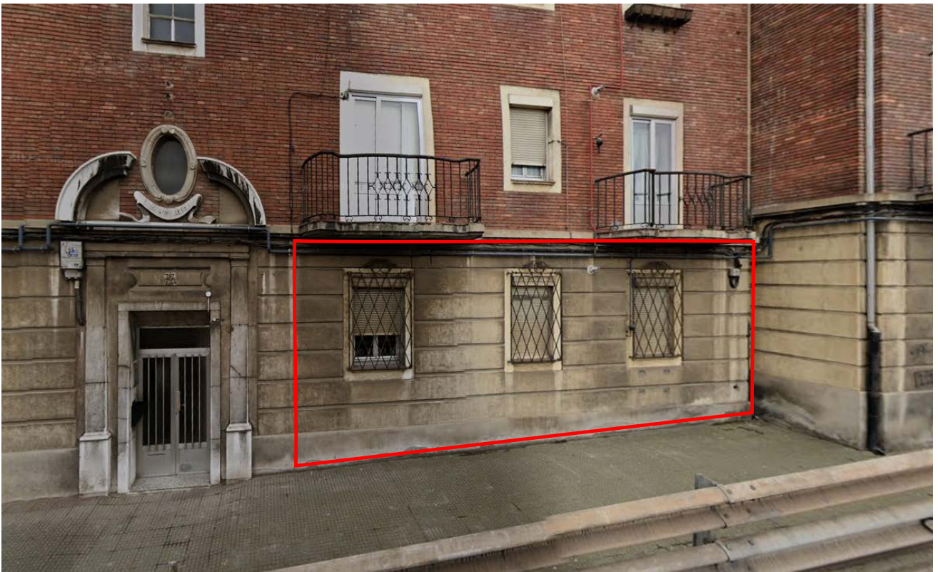
Detalle fachada principal de la vivienda – Tres ventanas
