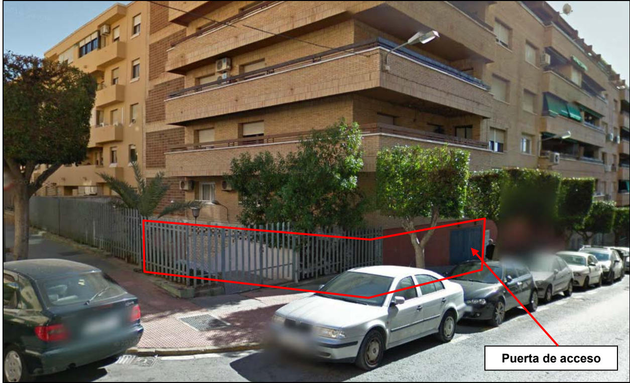
Fachadas a calle San Antón y calle Reg. de La Corona (por donde tiene el acceso)
