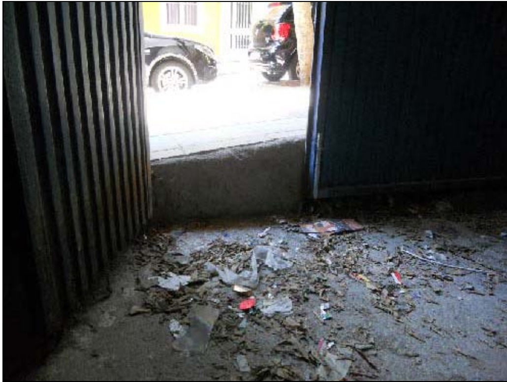
Escalón de acceso al local (35 cm)
