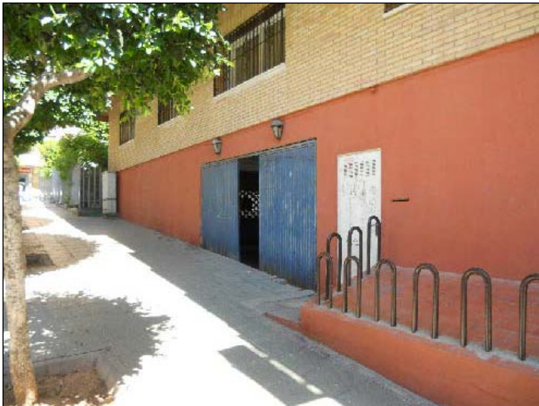
Fachada a calle Reg. de la Corona (donde se aprecia la pendiente de la calle)
