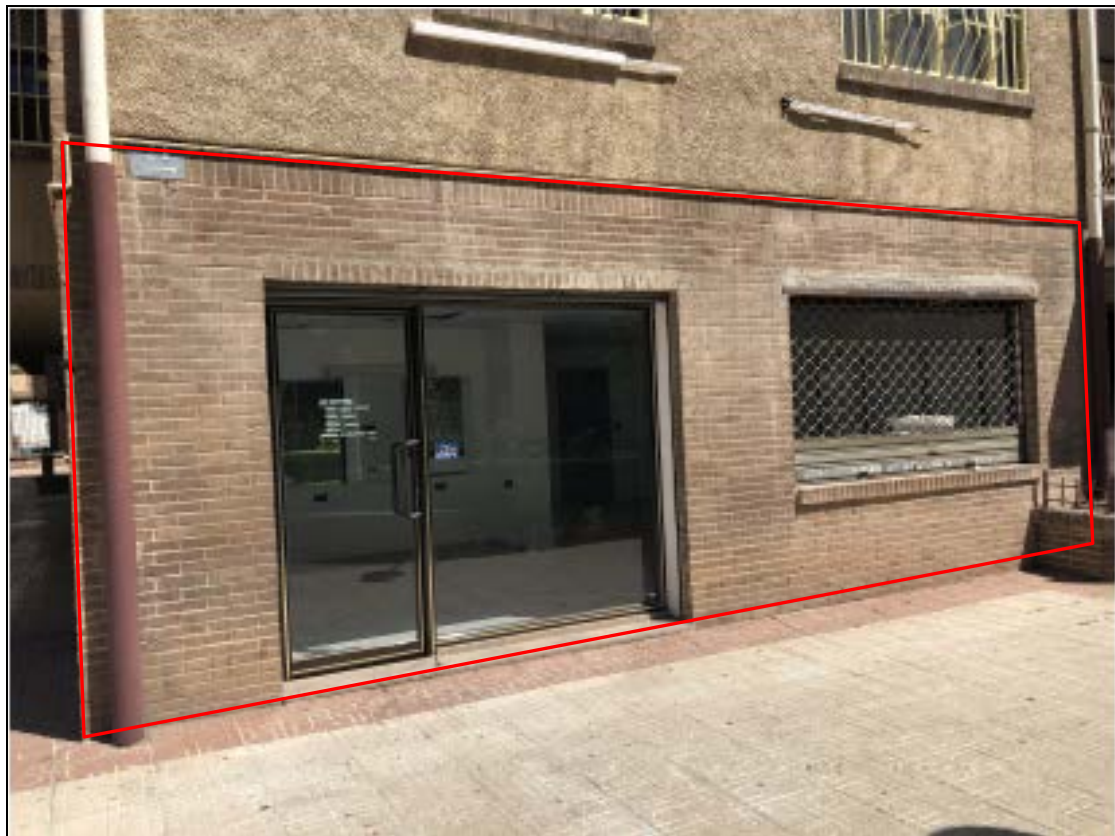
Detalle de fachada principal con puerta de acceso
