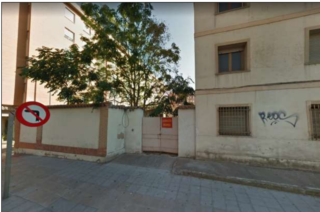
Detalle puerta acceso en calle Ronda de Toledo
