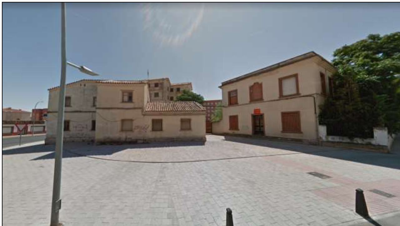
Detalle de edificaciones
