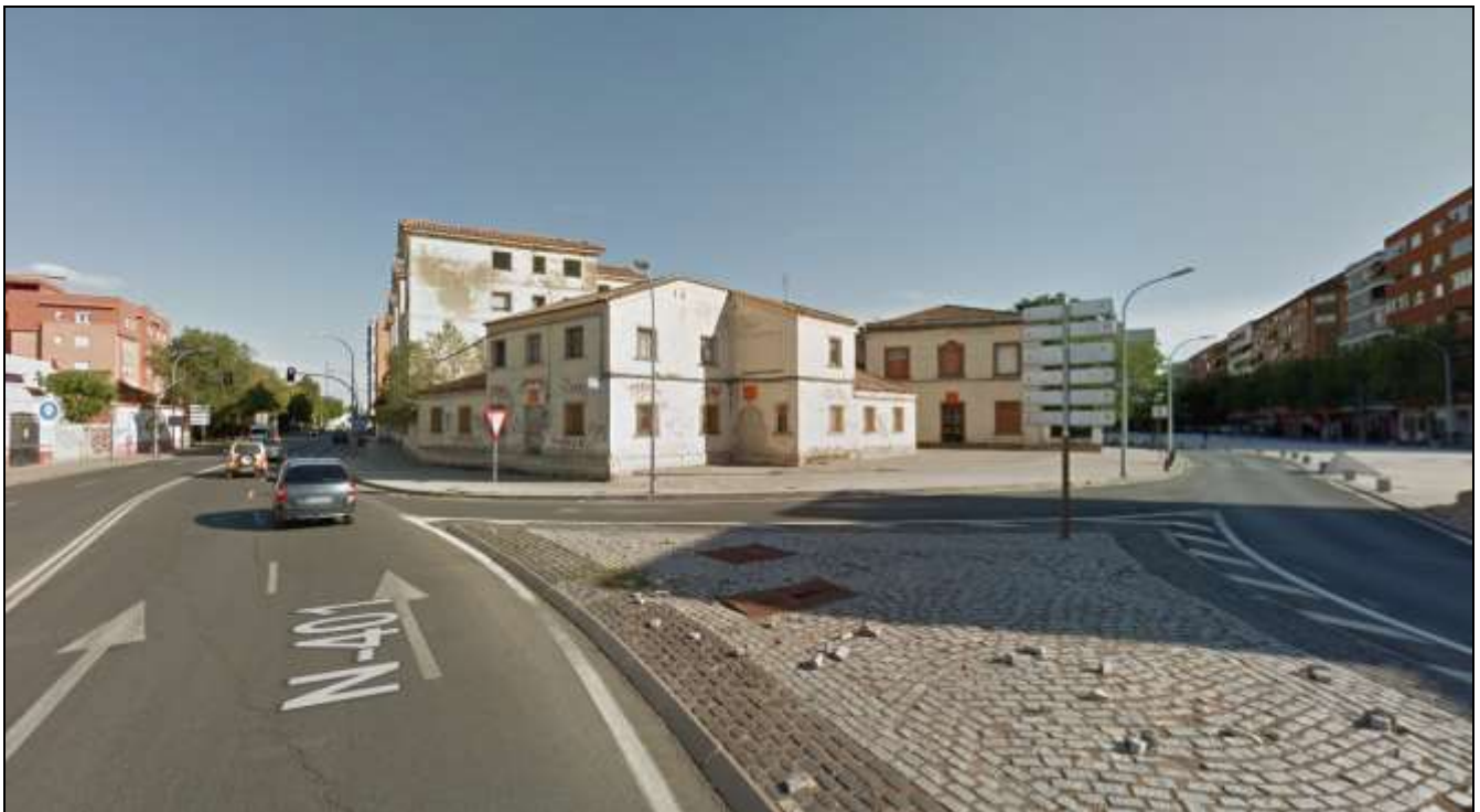
Vista de algunas edificaciones desde la Ronda de Toledo
