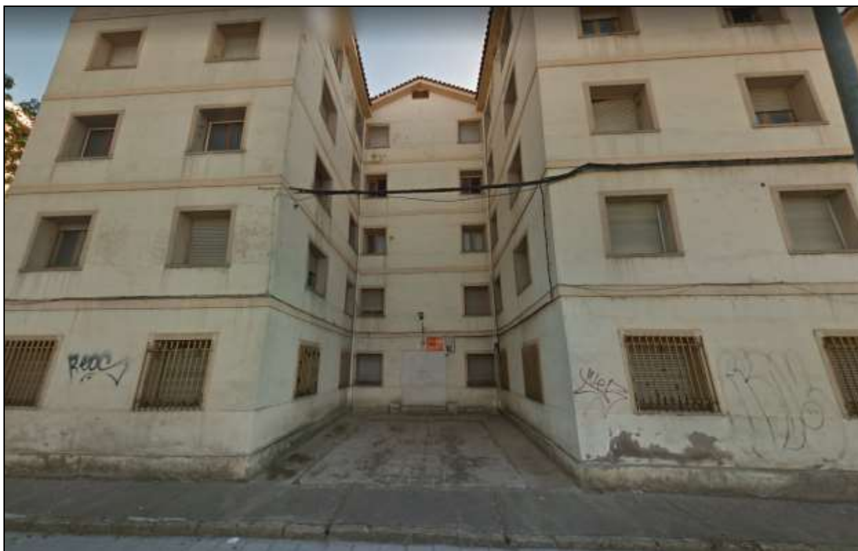
Detalle de edificio calle Ronda de Toledo
