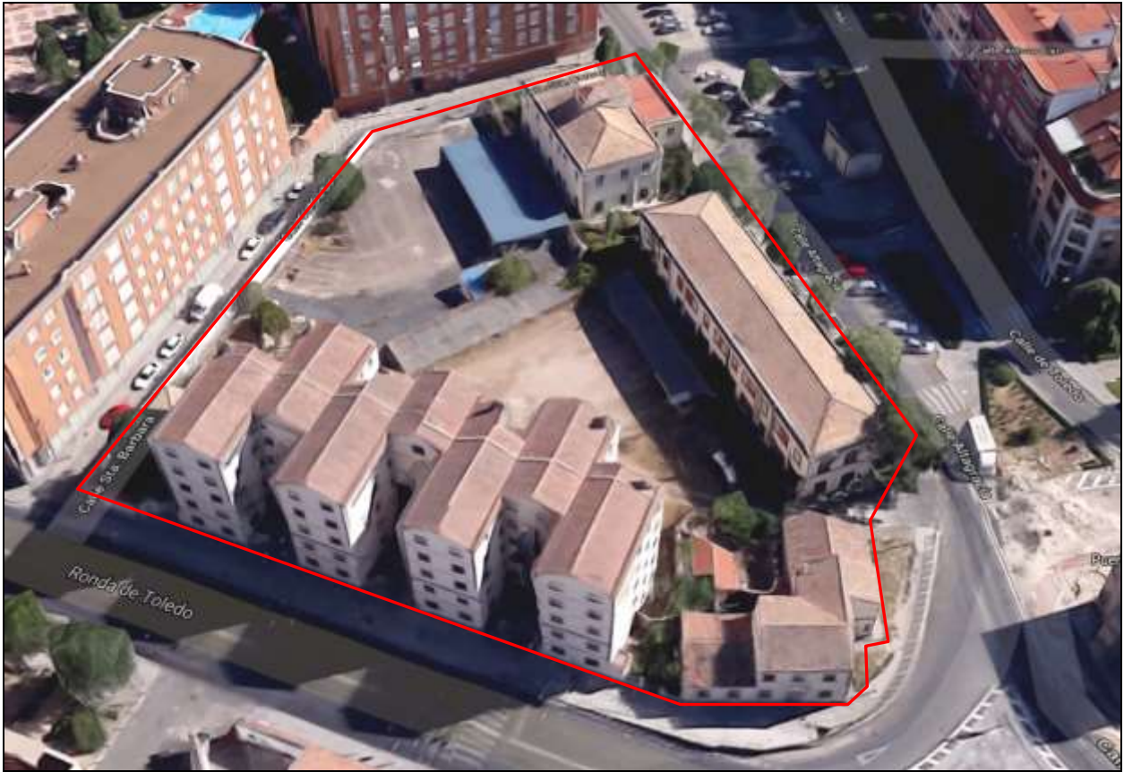
Vista aérea de la parcela y sus edificios que la integran
