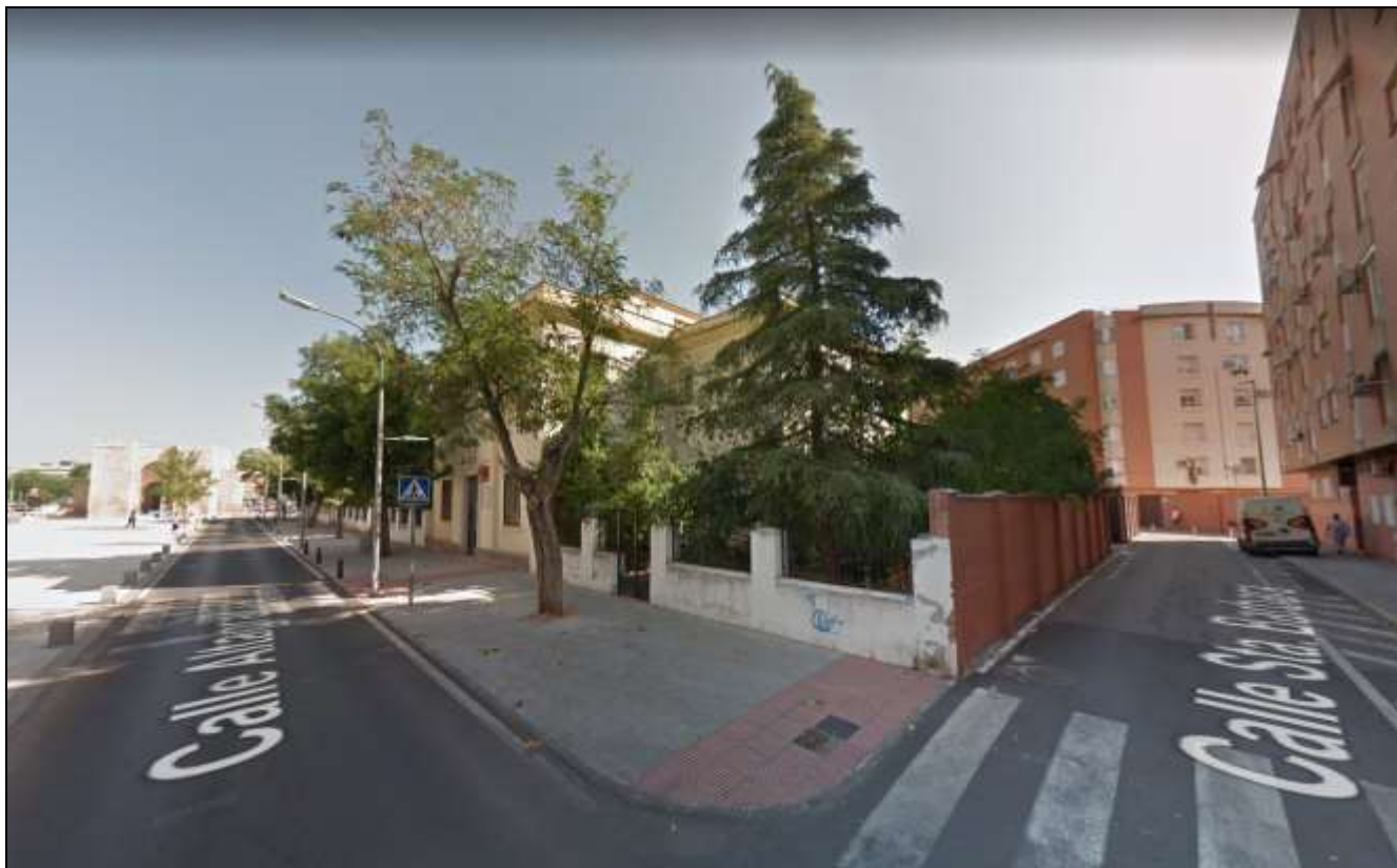
Vista desde la calle Altagracia- Esquina Suroeste y linderos Su (Calle Santa Bárbara) y Oeste (Calle Altagracia)
