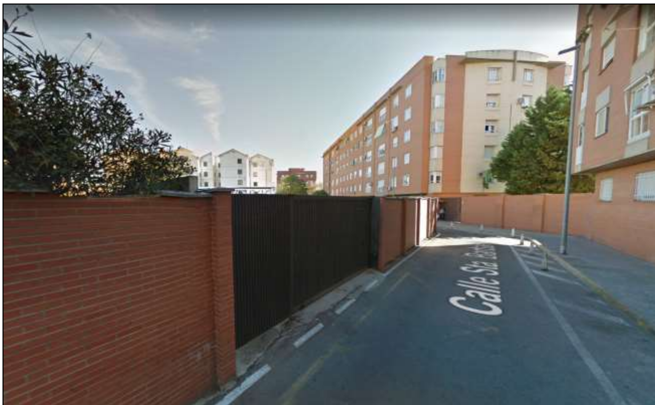
Vista de la puerta de acceso en calle Santa Bárbara
