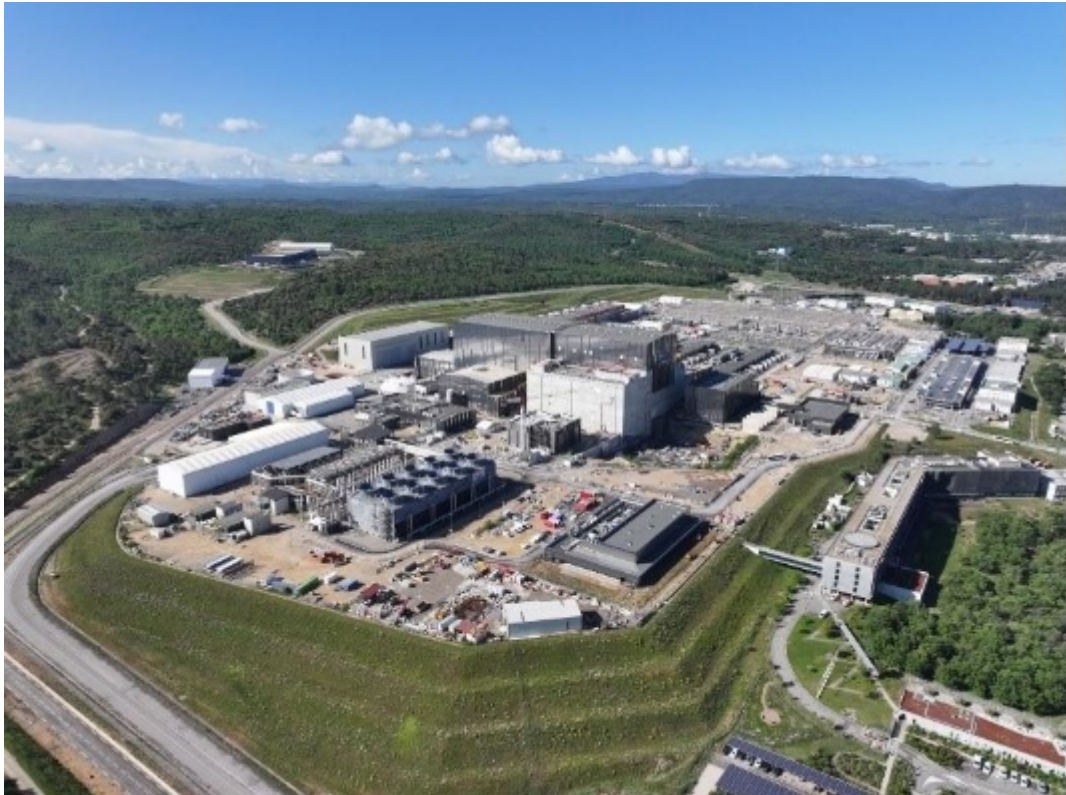
Figura 3. Vista aérea con dron del tokamak de ITER y del emplazamiento en construcción. 14-05-2025.
