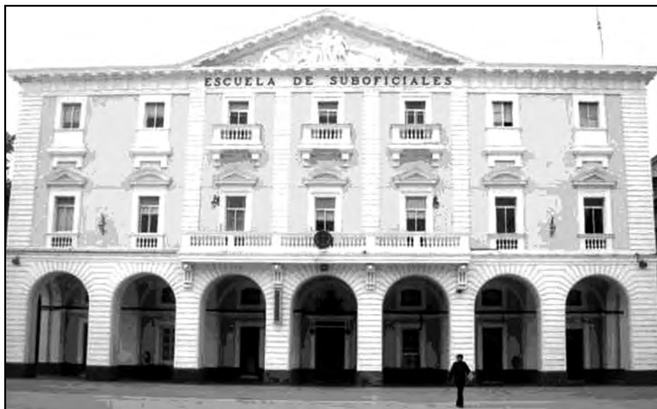
Figura 38. – Escuela de Suboficiales de la Armada.
