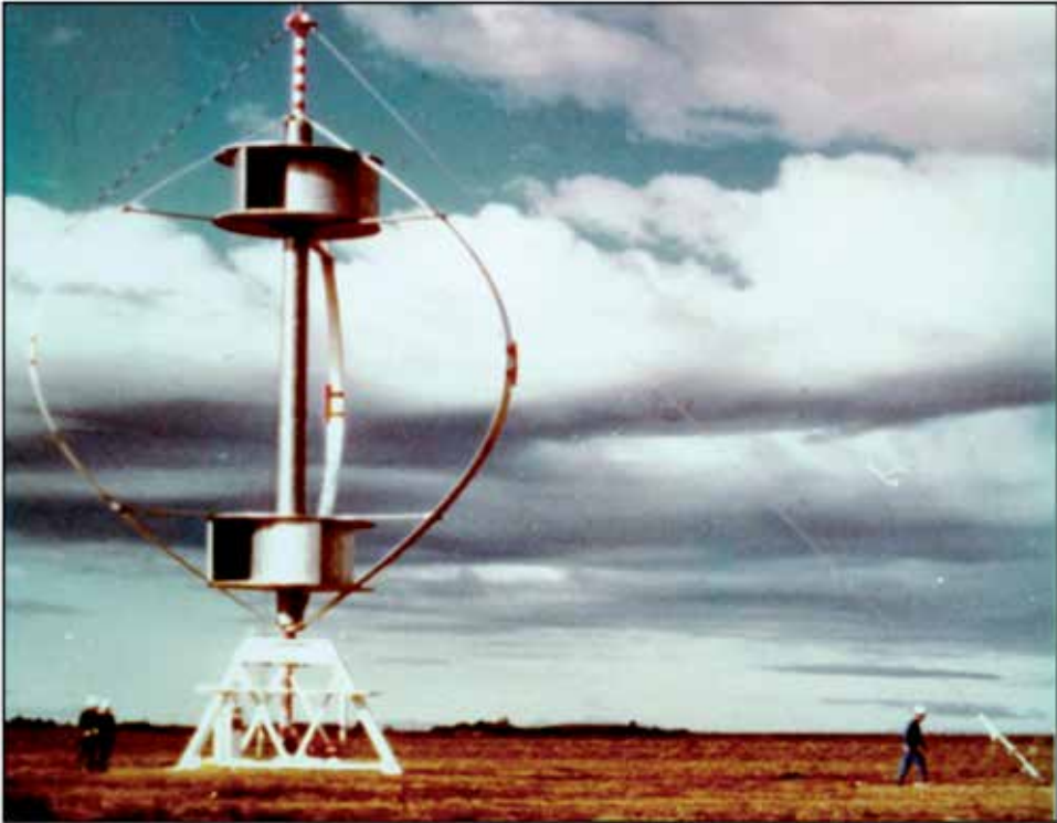
Figura 4.— Aerogenerador tipo Darrieus de eje vertical 20 kilogramos/voltios/amperios.
