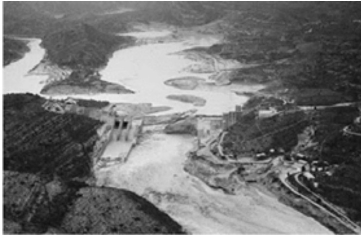
Figura 2. Imagen aérea de la Presa de Tous reventada. Fuente: ABC.
