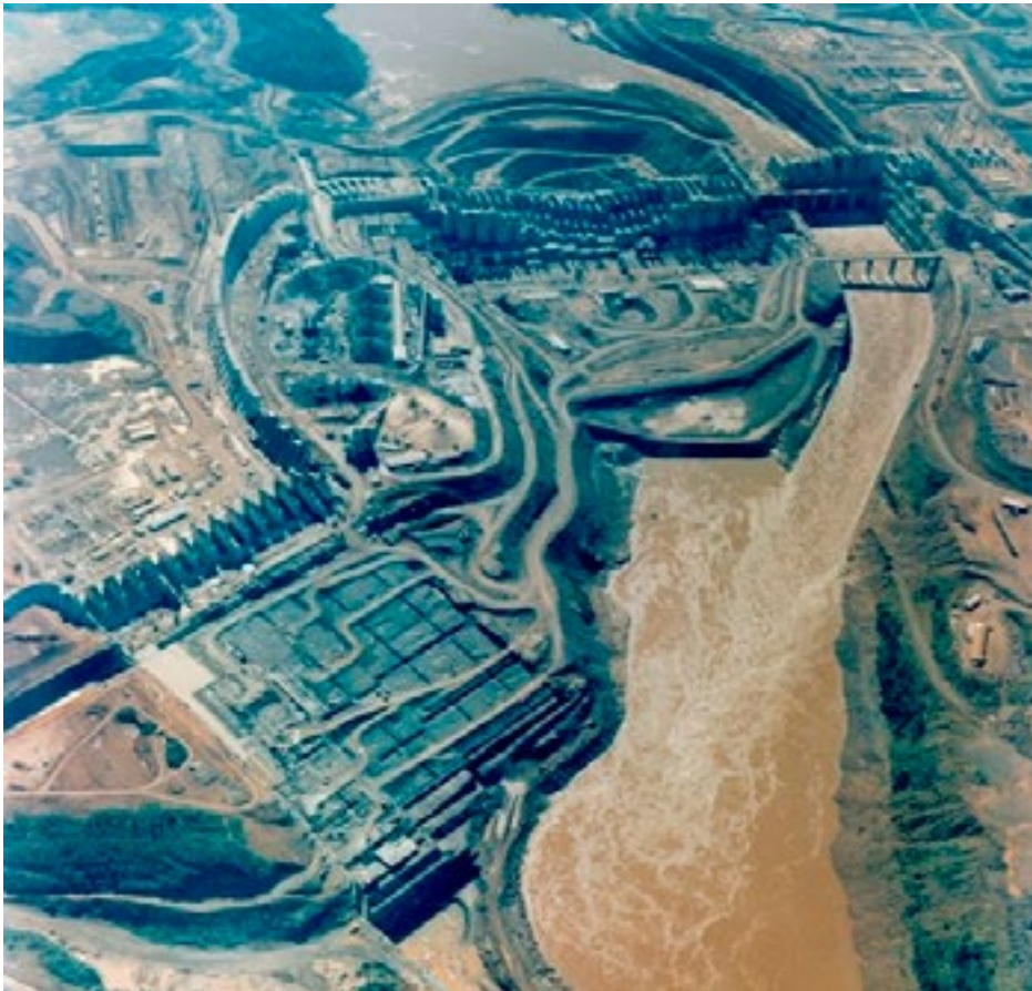
Figura 2. Obras de Itaipú. Fuente: Diario Itaipú Electrónico .
