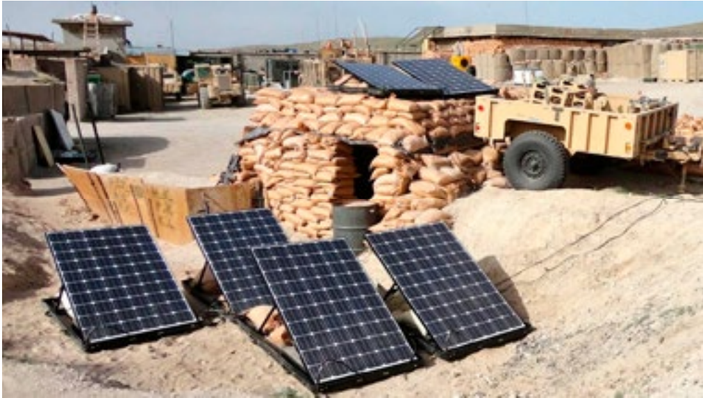
Figura 1. Paneles solares «rugerizado» en FOB Ghazni (Afganistán). Fuente: US Army.
