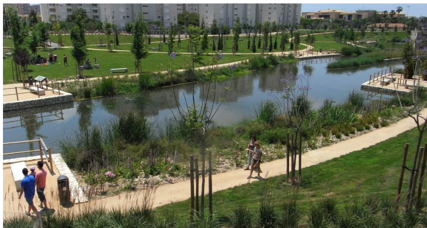
Figura 18. Parque La Marjal (playa de San Juan, Alicante). Es un ejemplo de medida para hacer frente a las lluvias torrenciales y sequías de algunas zonas del Mediterráneo. Además de la función de ocio y esparcimiento, puede almacenar hasta 45.000 m 3 de agua. El agua se lleva posteriormente a la planta de depuración de aguas residuales para su reutilización con fines de riego urbano principalmente, a través de los 70 km de redes de agua regenerada de la ciudad, por lo que también da apoyo para el uso racional de agua y para hacer frente a épocas de sequía 53 .
