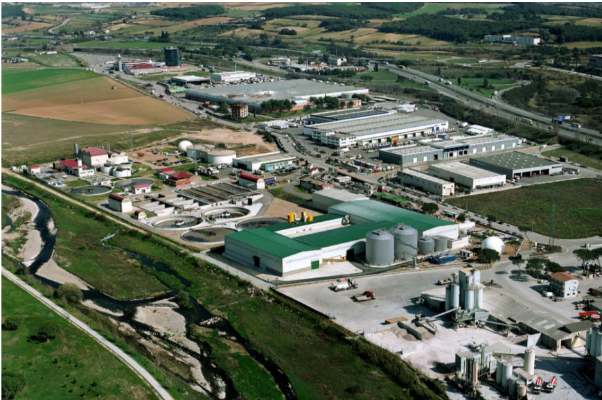
Figura1. Área de la Planta de Digestión Anaeróbica y de Compostaje del CGRVO y la Depuradora de Granollers del CBT 3.
