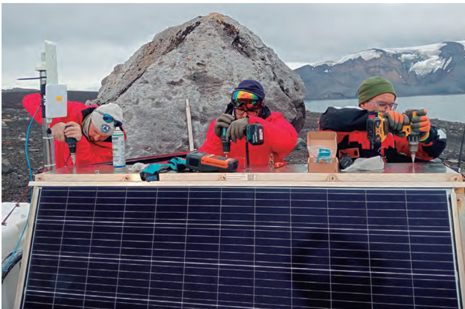
Instalación de las infraestructuras necesarias para una estación meteorológica, destinada a la medición de presión, humedad y temperatura, cerca del refugio chileno de la Antártida.
