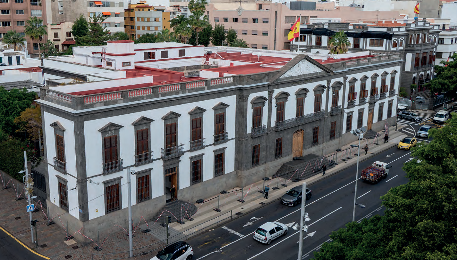
Fachada principal del Palacio de Capitanía de Santa Cruz de Tenerife.
