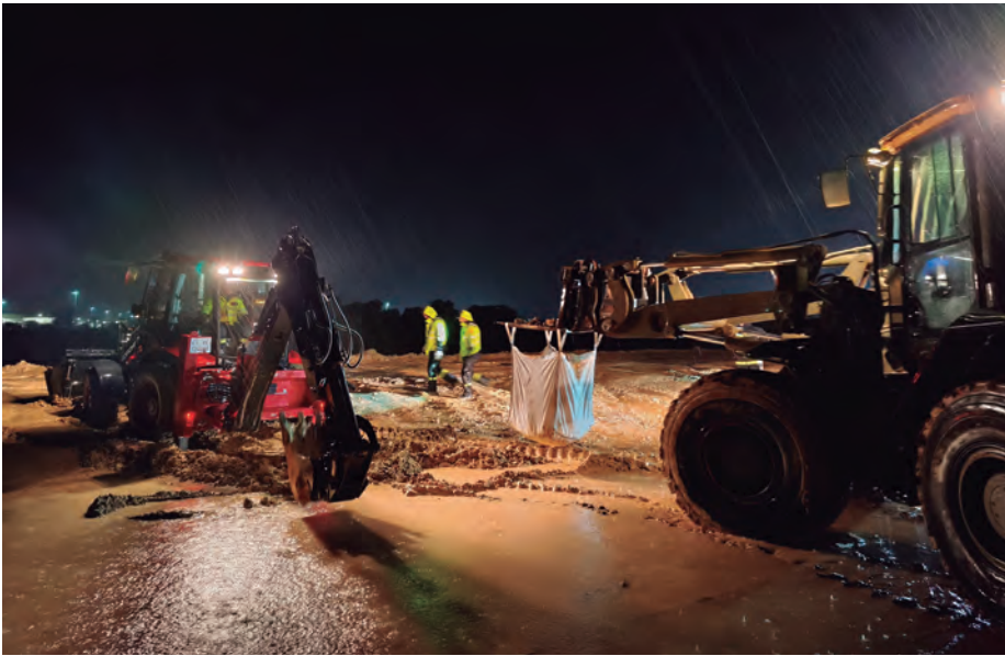
En la mina de Los Frailes, en Aznalcóllar (Sevilla), efectivos de la UME llenan de arena los sacos que utilizaron para construir diques e impedir que los residuos llegaran a los ríos.
