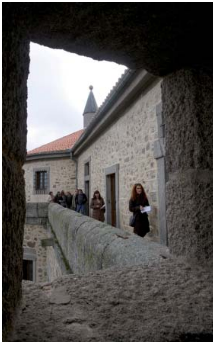
Detalle del paseo que circunda la última planta del castillo y que forma parte del nuevo recorrido guiado por la centenaria fortaleza.
