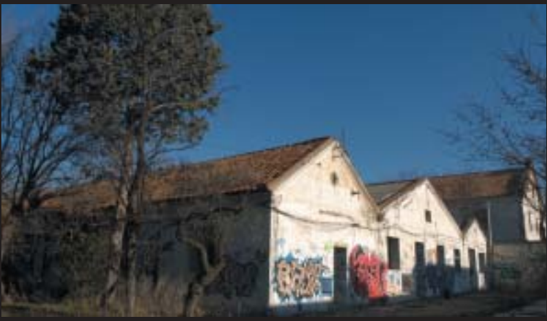
Estado actual de los pabellones del Cuartel Capitán Agradados en el paseo de Extremadura, cuyo derribo se iniciará a partir de junio.
