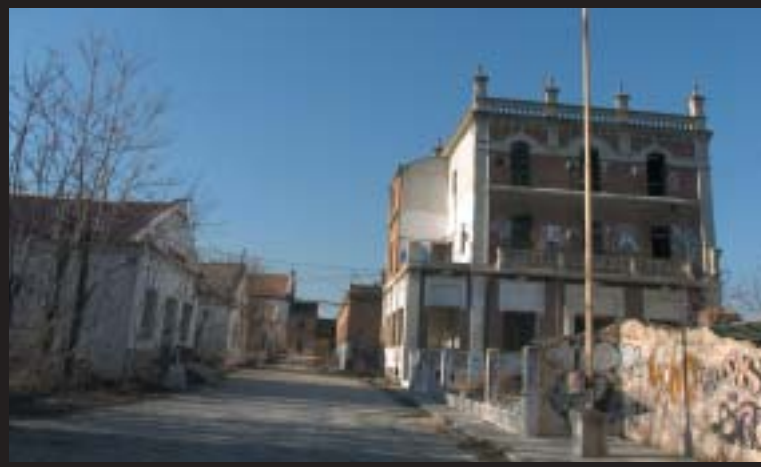
El más bello edificio militar de Campamento, el Cuartel General Muñoz Grandes, fue sede de una unidad de Artillería, el 19 a Caballo.
