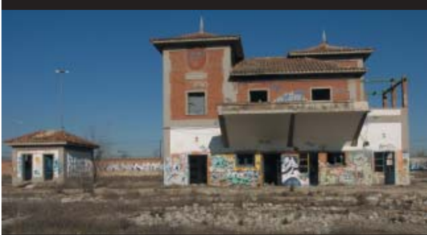
La Estación Ferroviaria Militar de Campamento, desde hace años cerrada, será una de las primeras instalaciones militares en ser demolidas.
