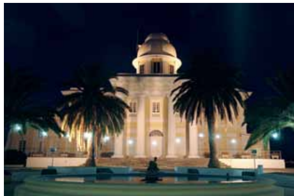
Fachada principal del Real Instituto y Observatorio de la Armada, situado en la localidad gaditana de San Fernando.
