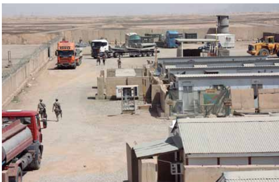
La base se construye en las proximidades de Besmayah sobre una superficie de 45.000 metros cuadrados y ha sido diseñada para albergar a unas 450 personas.
