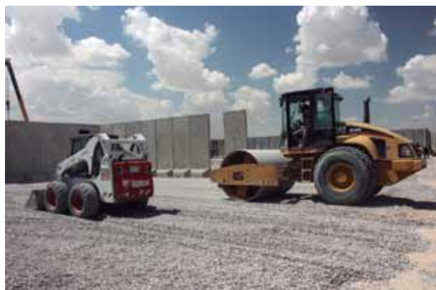
La capacidad operativa de los ingenieros se ha reforzado con llegada de nuevos equipos y maquinaria.
