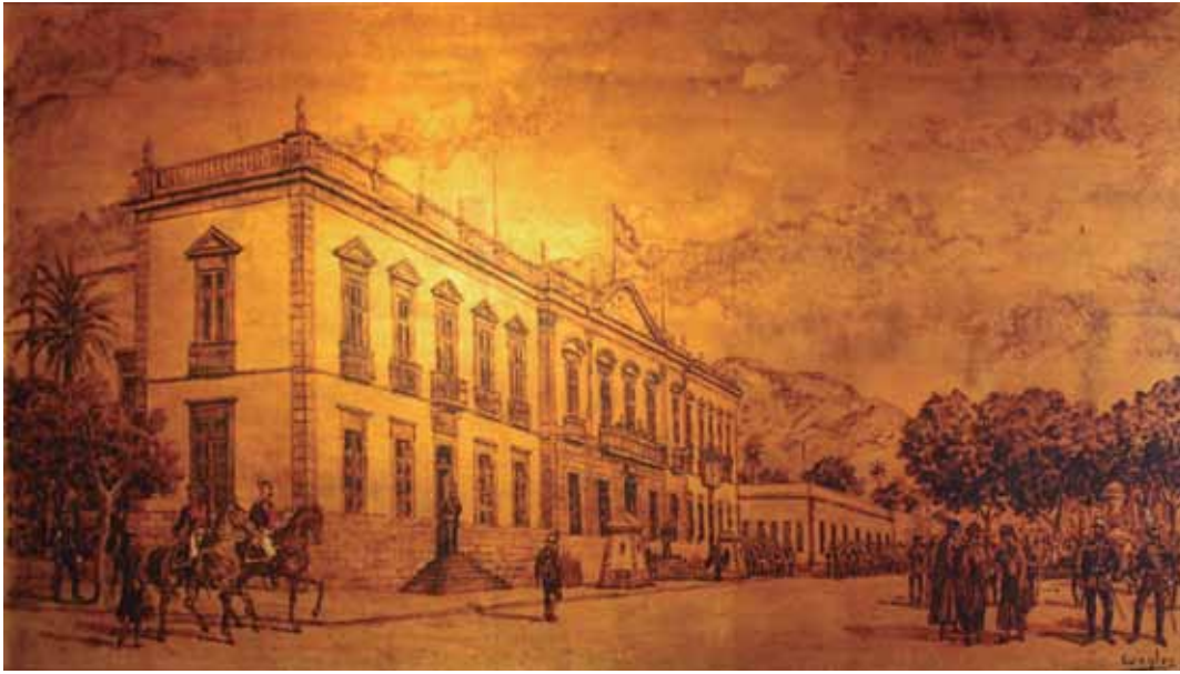
Fachada del Palacio de la Capitanía General de las islas Canarias, en Santa Cruz de Tenerife.
